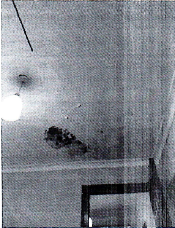
Hall de acceso afectado por filtraciones de baños de P.A.
